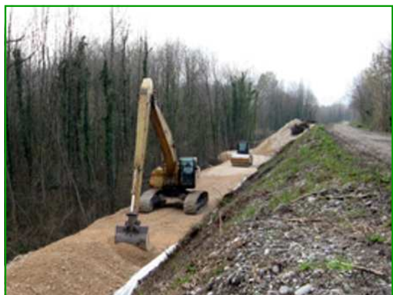
Mise en œuvre du remblai
